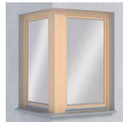
Tradycyjny rodzaj okna narożnego to połączenie szyb z użyciem narożnego słupka drewnianego.
